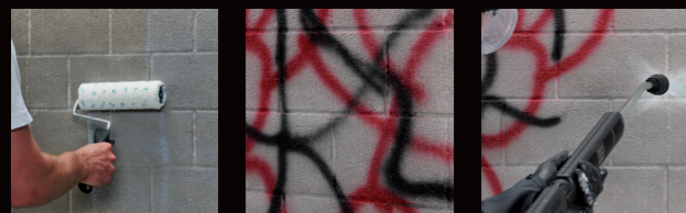
Nanášení produktů Zolpan 420 + Protection SG
